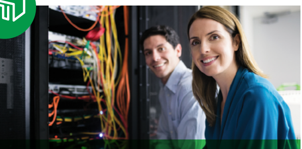
SERVIDORES DE ENTRADA E PEQUENOS DATA CENTERS
